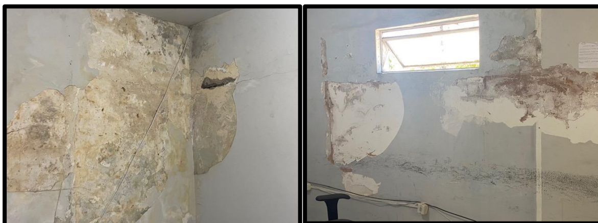
Figuras 140 e 141: Paredes internas da Central de Flagrantes. Fonte: MNPCT.
