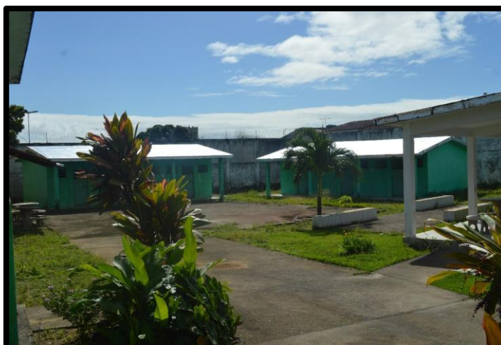
Figura 121: Módulos da unidade socioeducativa. Fonte: MNPCT.
