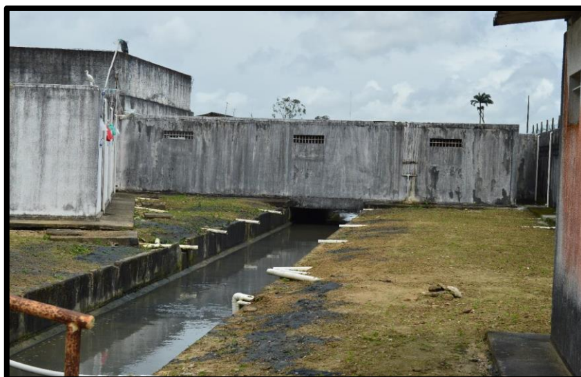
Figura 19: Vala de esgoto. Fonte: MNPCT.
