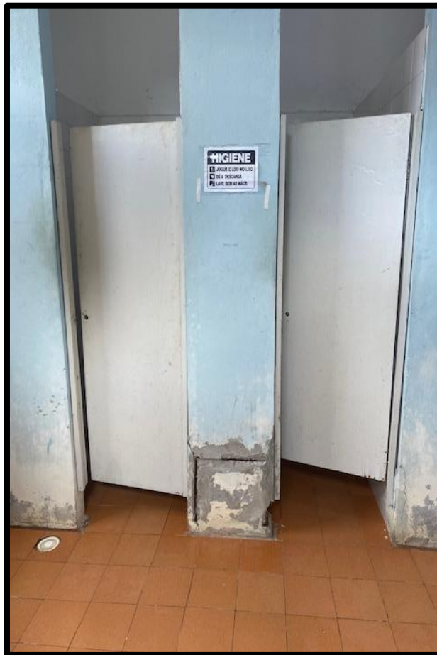
Figura 49: Banheiro dos servidores. Fonte: MNPCT.
