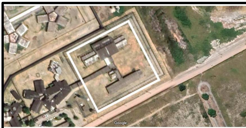
Figura 86: Vista aérea da EPFSL. Fonte: Google.
